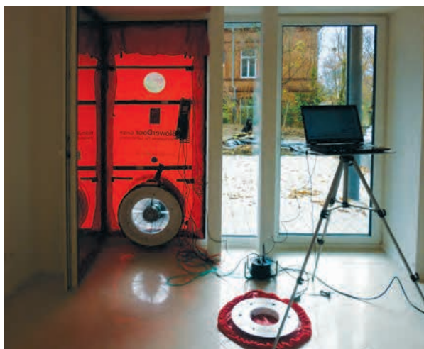
Der Folienrahmen mit Ventilator ist hier in eine Terrassentür eingebaut
